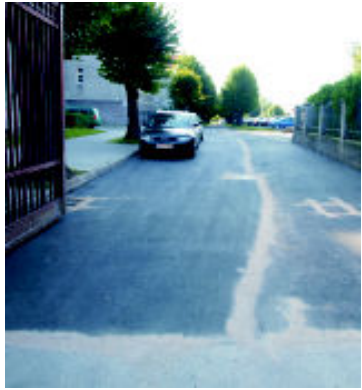
Utwardzenie nawierzchni drogi gminnej na przedłużeniu ul. Armii Krajowej.
