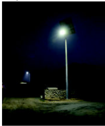
Montaż na terenie wiejskim lamp oświetleniowych zasilanych energią słoneczną.
