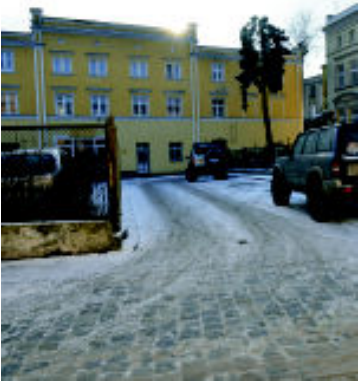
Budowa parkingów przy ul. Ciasnej.
