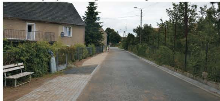
Wykonano II etap remontu ulicy Spokojnej
