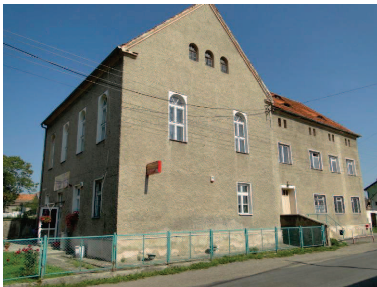
Fot. 1 - Widok budynku
