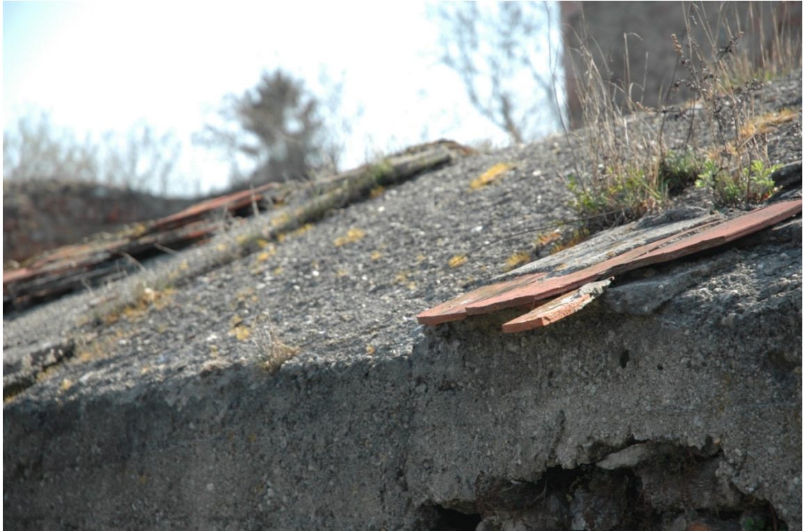
Fot. 12. Wylewka betonowa pokrywająca koronę muru.
