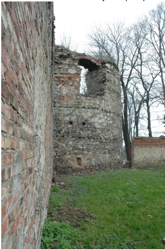
Fot. 40. Łuki okienne bastei wymagające rozebrania i odbudowy z zachowaniem oryginalnego kształtu i zabytkowego charakteru
