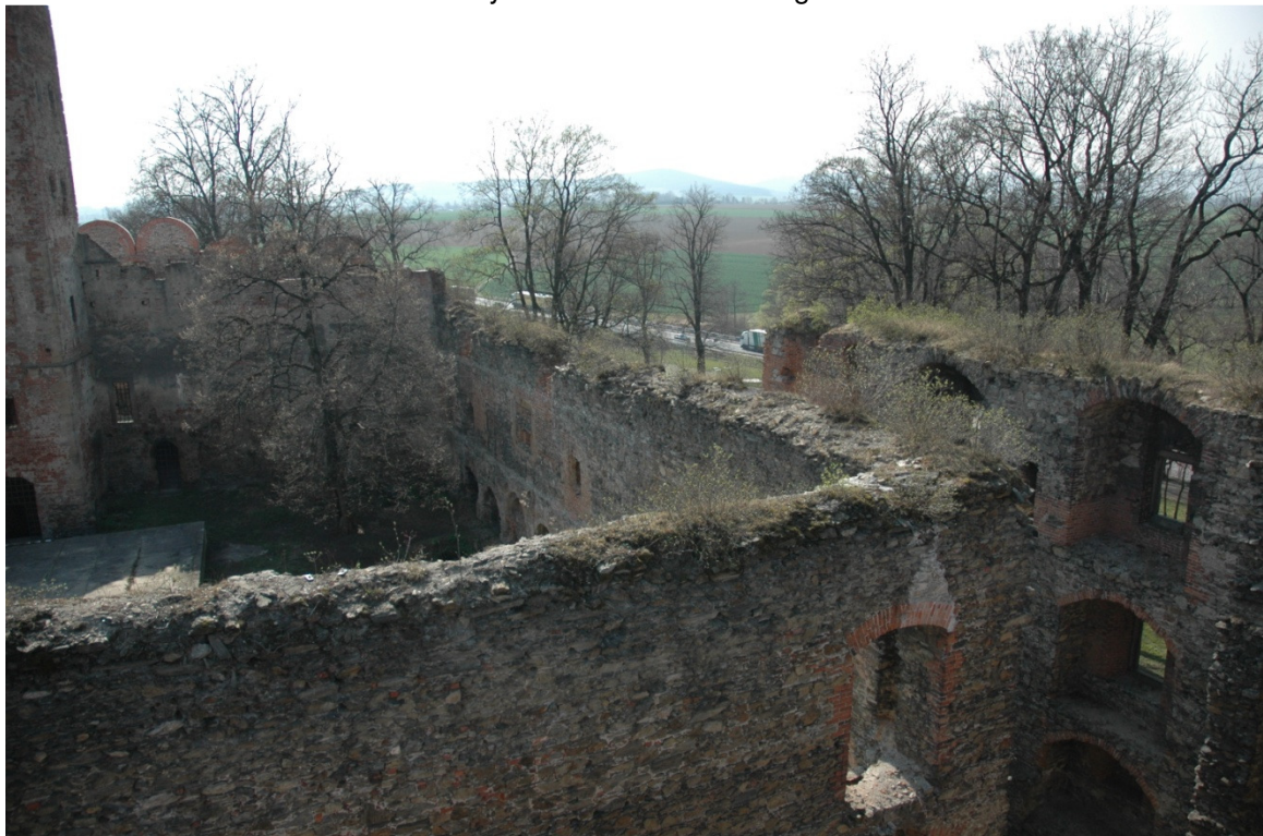
Fot. 31. Korona w znacznym stopniu porośnięta trawą i krzewami wyrosłymi na warstwie humusu.
