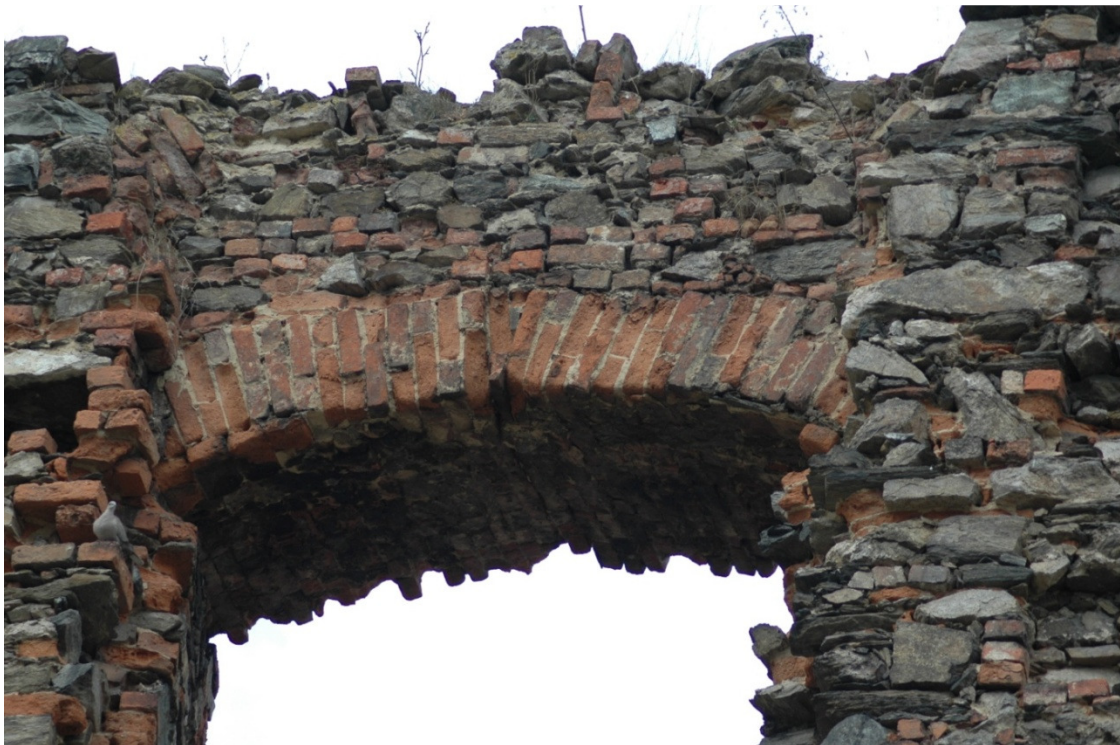
Fot. 7. Nadproże okienne bez podparcia drewnianymi belkami.
