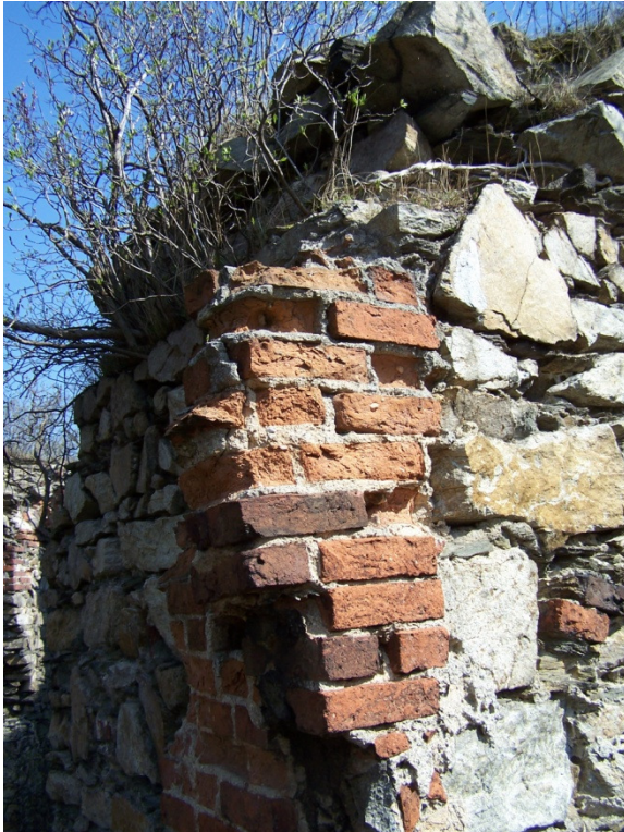
Fot. 39. Korona muru w znacznym stopniu porośnięta krzewami i mocno zakorzenionymi drzewkami.
