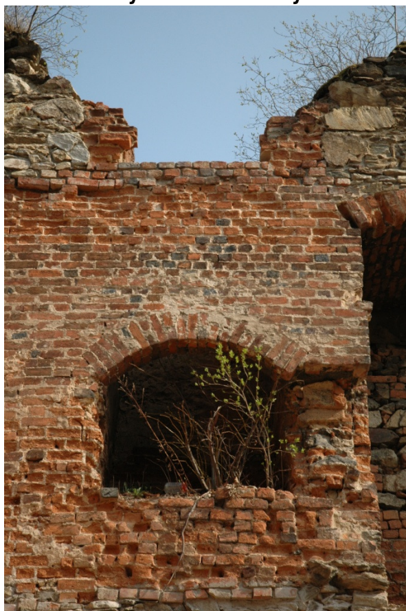
Fot. 33,34. Pozostałości otworów okiennych wymagające odbudowy w celu wykonania wieńca żelbetowego. Należy użyć starą cegłę a do spajania użyć zaprawy wapienno – piaskowej (trassowej) lub zaprawy na białym cemencie.
