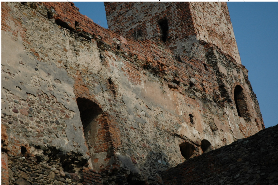
Fot. 36. Część korony wymagająca wyrównania do poziomu umożliwiającego wykonanie wieńca żelbetowego. Należy użyć starą cegłę a do spajania użyć zaprawy wapienno – piaskowej (trassowej) lub zaprawy na białym cemencie.
