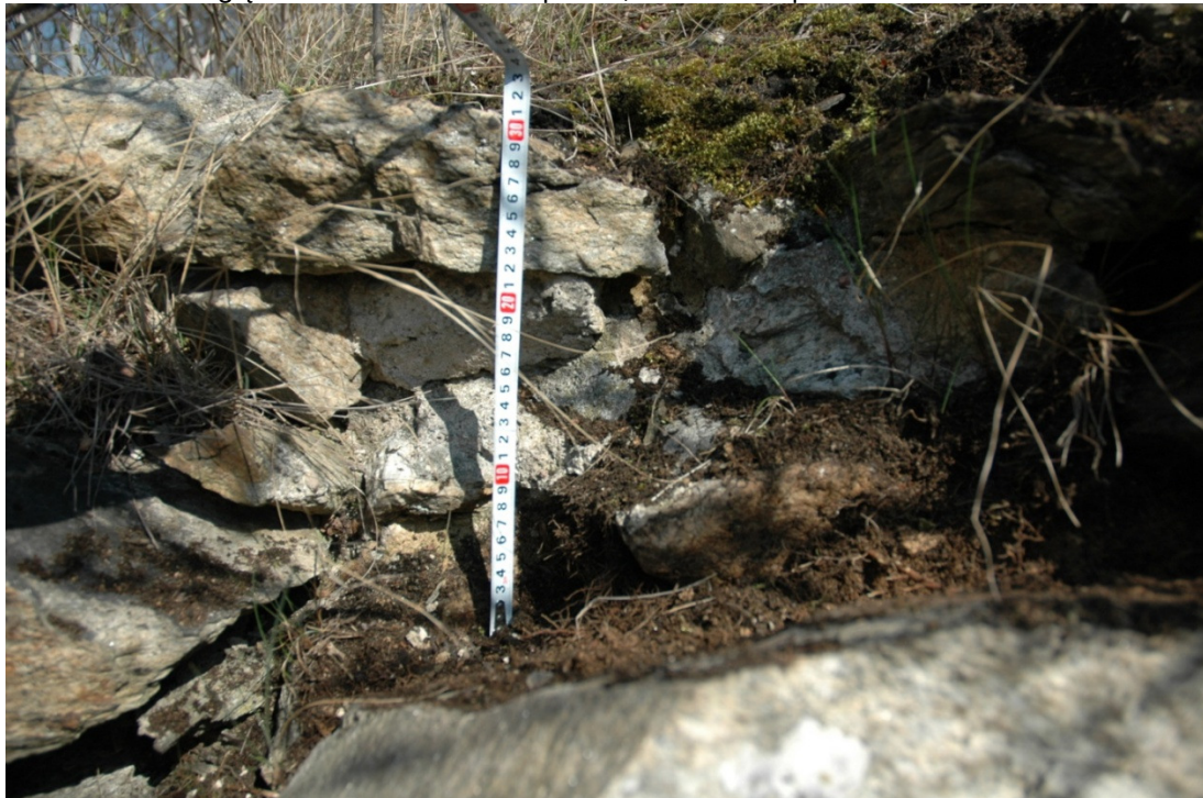
Fot. 19. Trzy warstwy luźno leżących kamieni nie związanych zaprawą.
