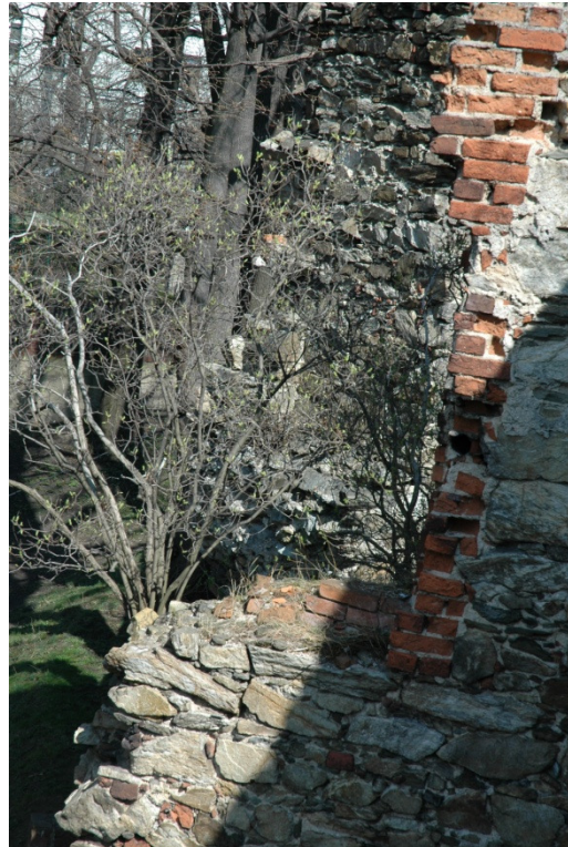
Fot. 39. Korona muru w znacznym stopniu porośnięta krzewami i mocno zakorzenionymi drzewkami.
