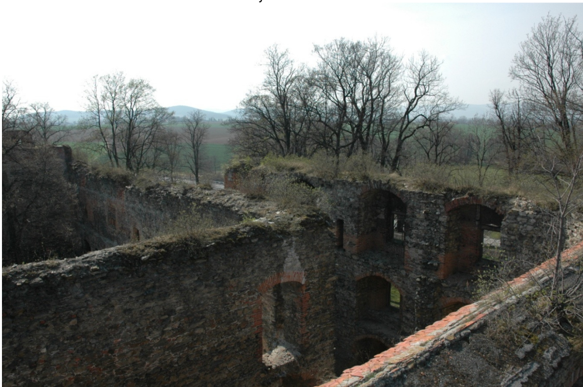
Fot. 27. Korona w znacznym stopniu porośnięta trawą i krzewami.
