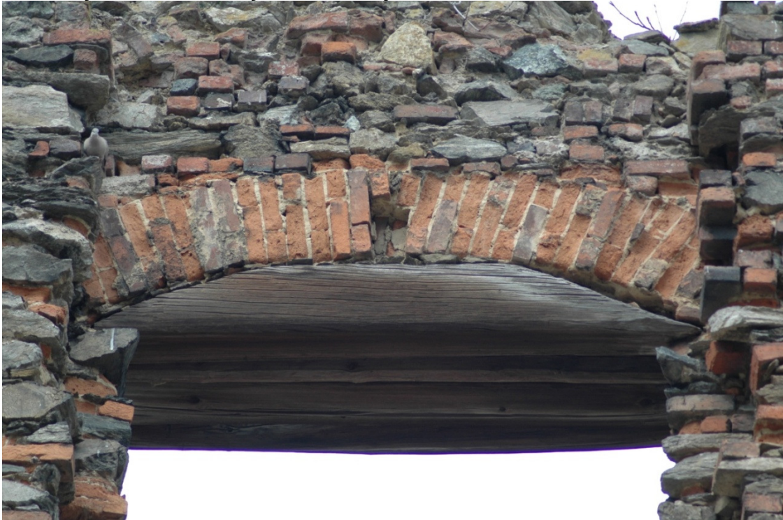
Fot. 6. Drewniane belki osadzone poziomo w nadprożach okien pełniące funkcję wypełnienia światła okien.
