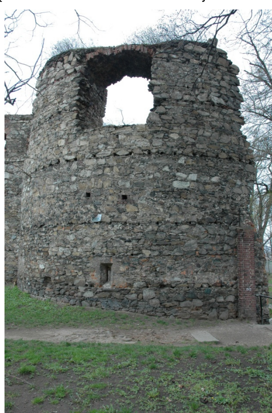
Fot. 40. Łuki okienne bastei wymagające rozebrania i odbudowy z zachowaniem oryginalnego kształtu i zabytkowego charakteru
