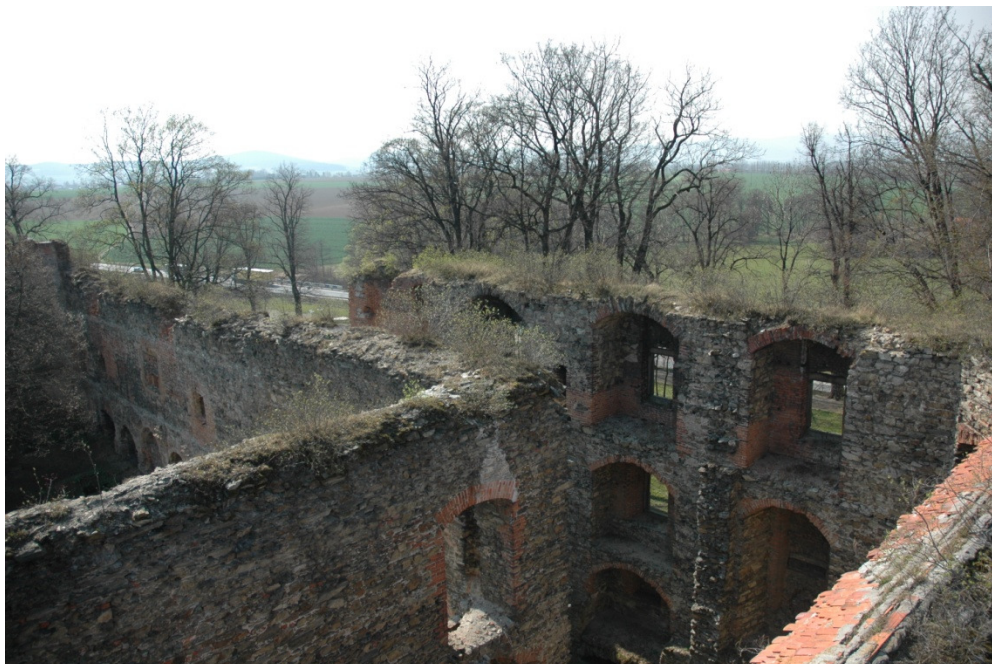
Fot. 32. Widok połączeń narożników korony zachodniej i północnej
