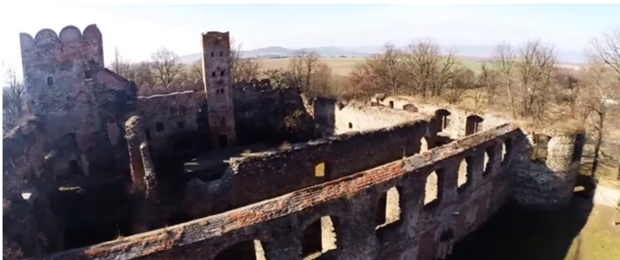
Fot 1. Widok zamku, na pierwszym planie część północna zamku, dalej widoczna korona murów w części zachodniej.
