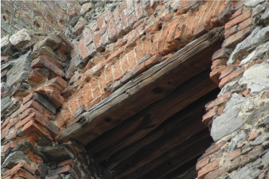
Fot. 8. Detal podparcia okiennego
