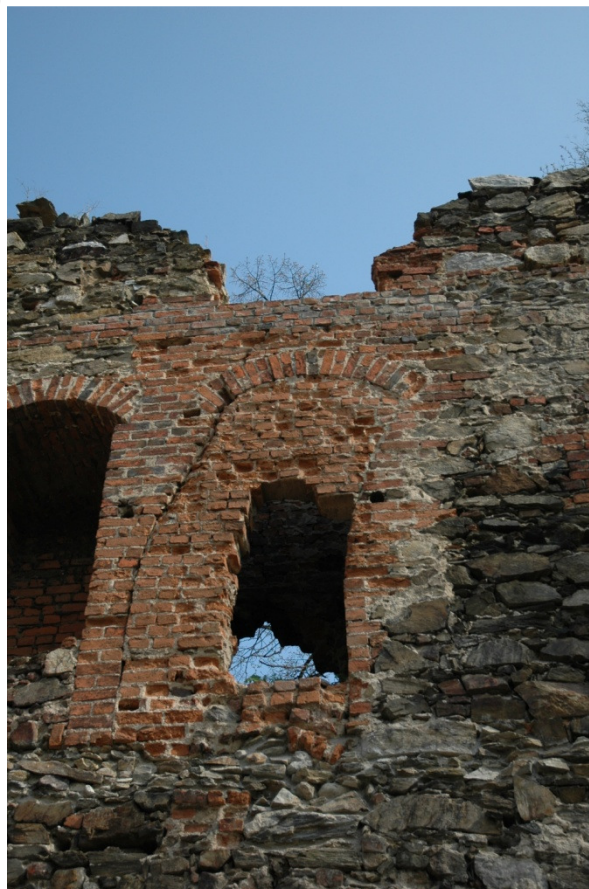
Fot. 33,34. Pozostałości otworów okiennych wymagające odbudowy w celu wykonania wieńca żelbetowego. Należy użyć starą cegłę a do spajania użyć zaprawy wapienno – piaskowej (trassowej) lub zaprawy na białym cemencie.
