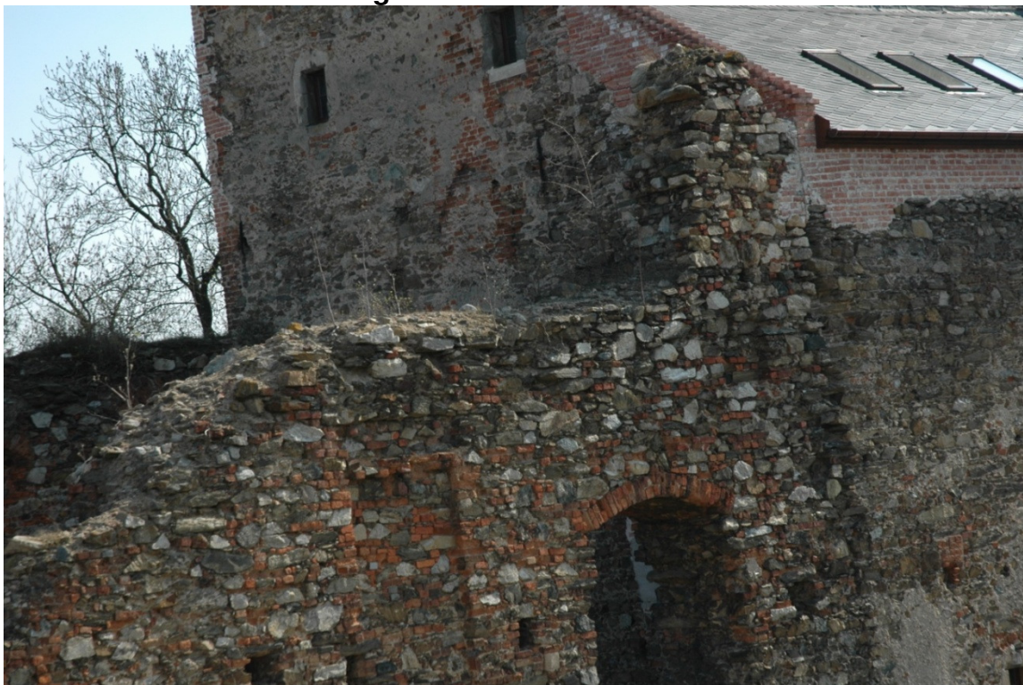
Fot. 22. Korona muru porośnięta w małym stopniu przez drobne krzewy.
